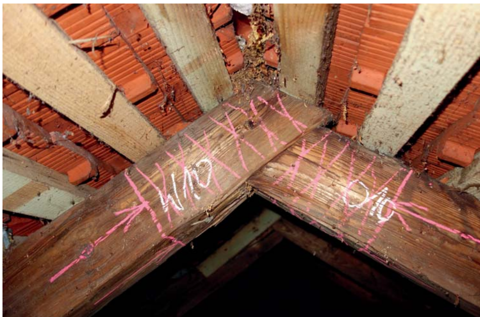
Durch die eindringende Feuchtigkeit sind zahlreiche Balkenköpfe an der Traufe und Firsthölzer verfault und müssen erneuert werden.
